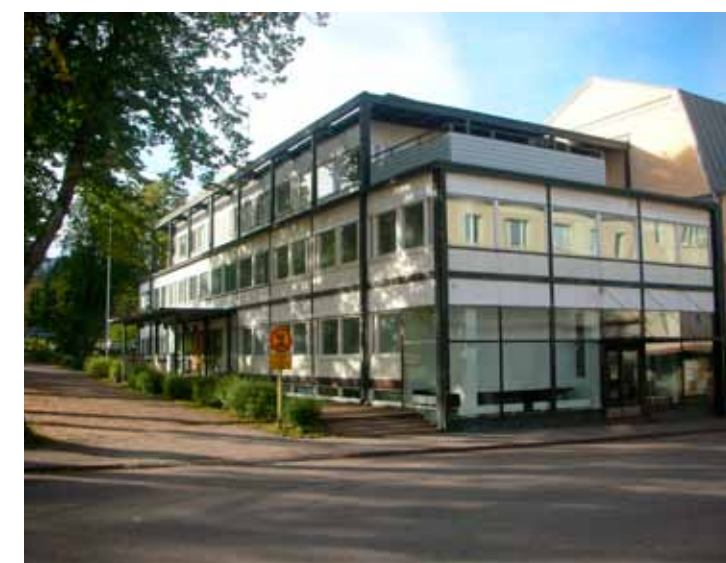
Församlingsgården i Lovisa, med det nyrenoverade utrymmet Tikva i bottenvåningen, under gatunivå.
